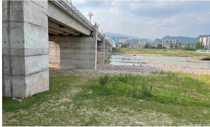
桥梁工程区现状
