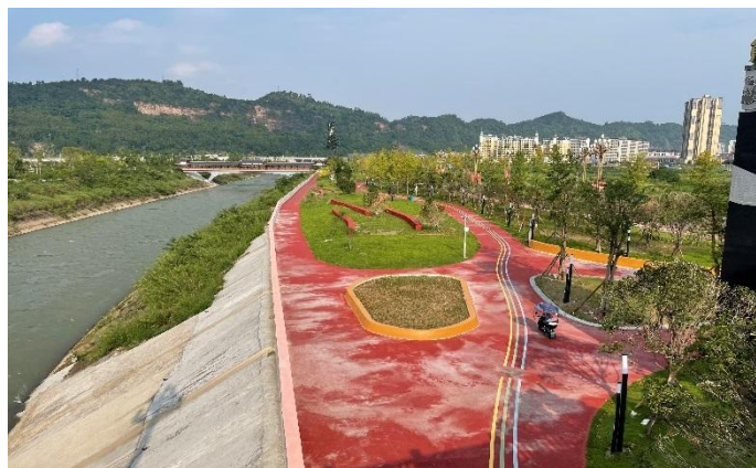
施工临时设施
